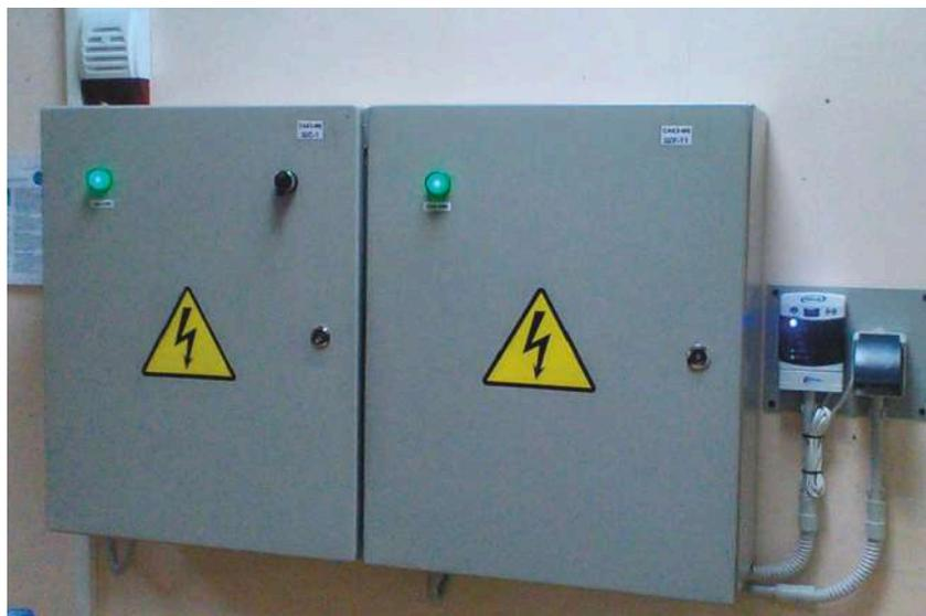
ШСПД предназначен для сбора и передачи данных аварийных сигналов на диспетчерский пункт дежурных эксплуатирующих служб.
